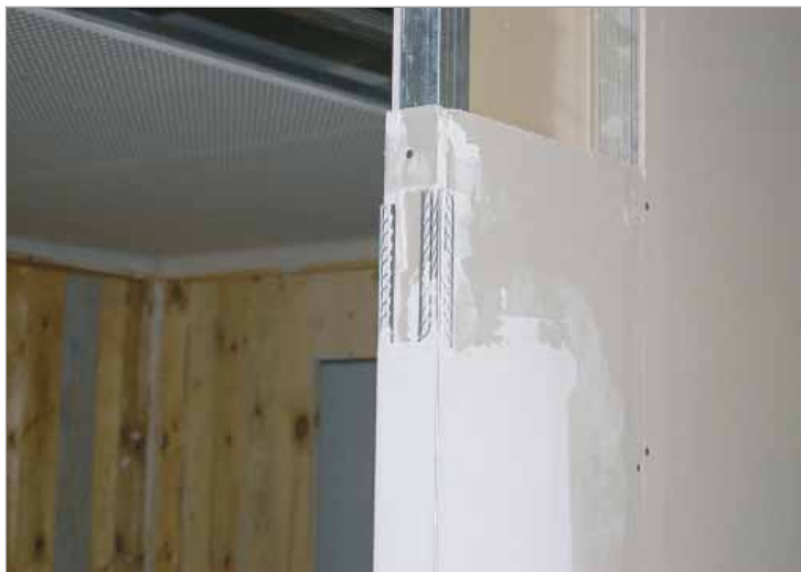
Применение сетчатых тянутых уголков из оцинкованной стали производства «ДиПОС» на практических занятиях в Учебном центре КНАУФ в Новомосковске.
