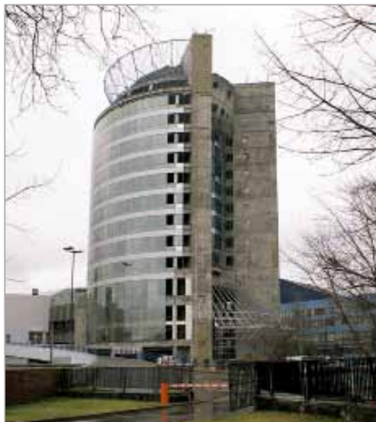
Павильон № 11 выставочного комплекса «Экспоцентр» в г. Москве.
