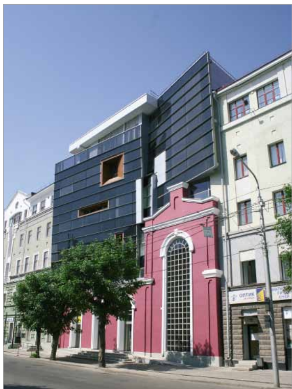
Корпус № 2 бизнес-центра «Капитал» по улице Карла Маркса в городе Уфе.
