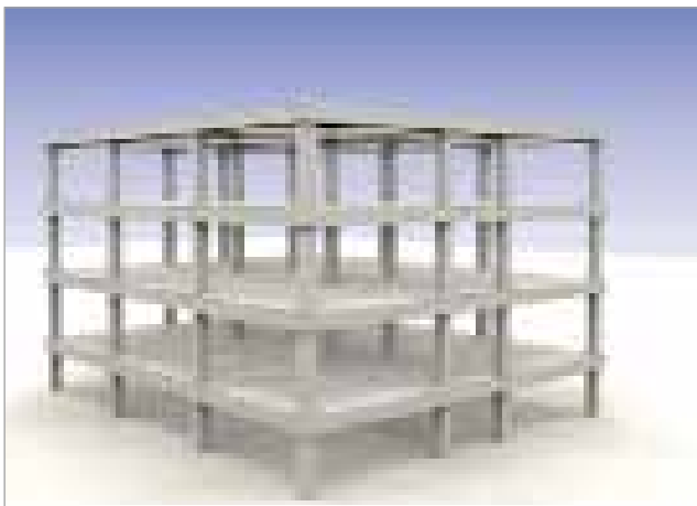
Монтаж каркаса здания.
