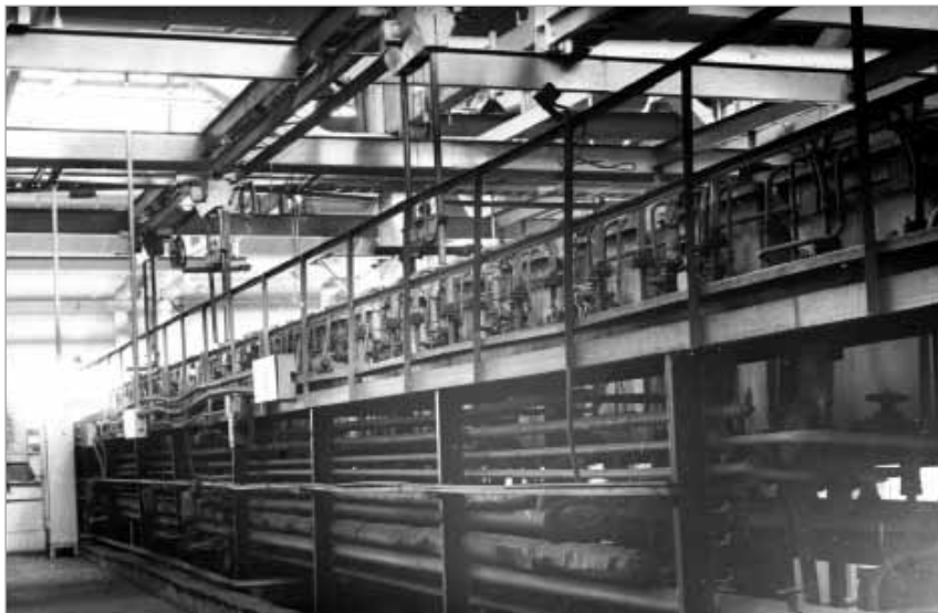
Раскладка трубопроводов под площадкой.
