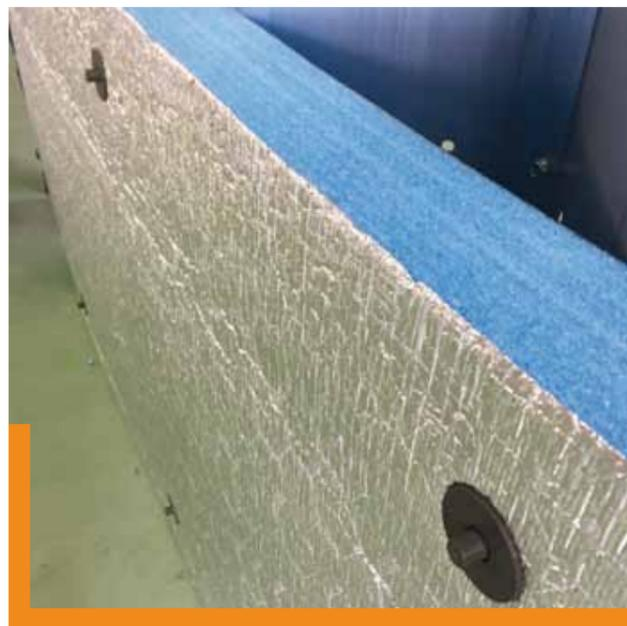
Рис. 1. Утепление бескаркасного ангара ПЕНОФОЛом толщиной 100 мм – массивной теплоизоляцией из вспененного полиэтилена с отражательным покрытием (алюминиевой фольгой)
