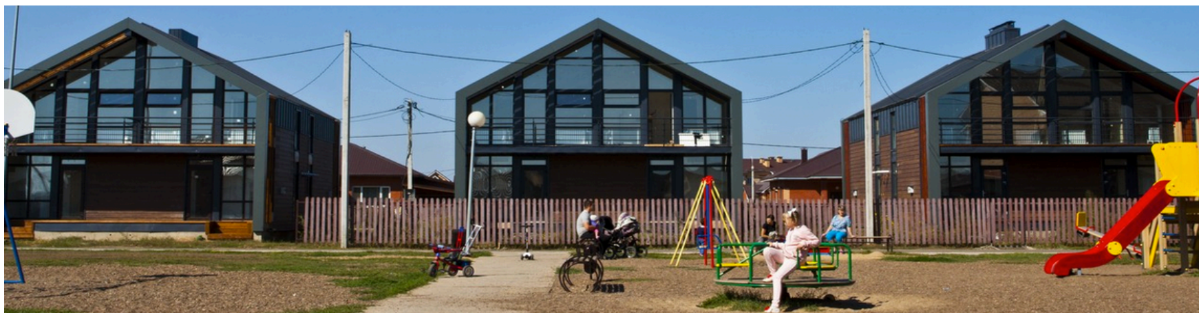
Строительстве энергоэффективного домов ДОН в Оренбурге
