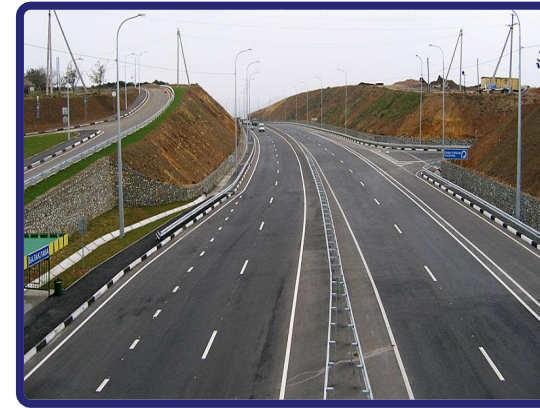
Гидроизоляция и защита дорожной инфраструктуры
