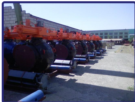
Изоляция СДТ и запорной арматуры
