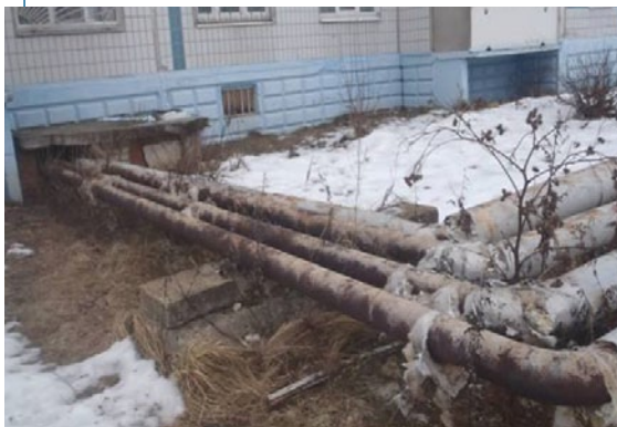
Рис. 1. Состояние действующих тепловых сетей.
