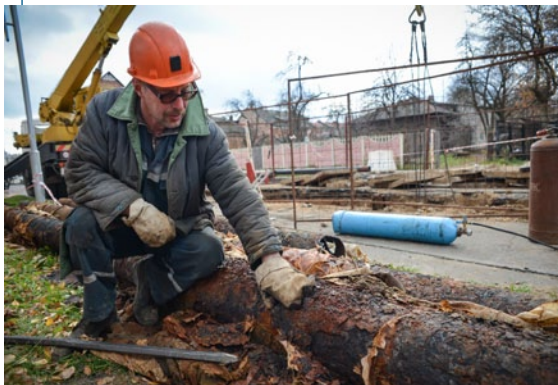
Рис. 2. Результат отсутствия антикоррозионного покрытия.
