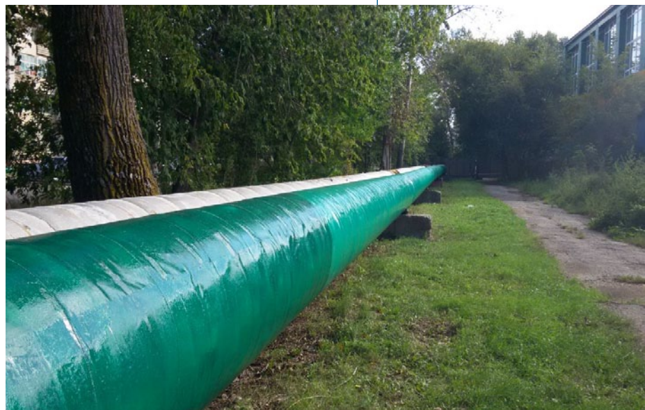
Рис. 5. Комплексное защитное покрытие из гидроизоляционного материала «Магистраль» на тепловой сети.
