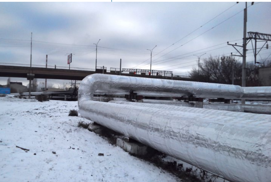
Рис. 6. Устройство тепловой сети с применением конструкции СТУ.
