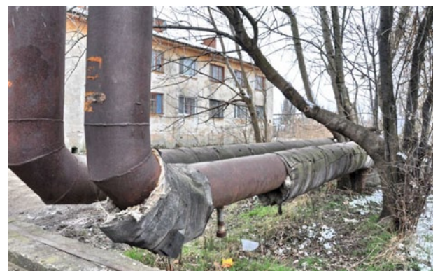
Рис. 3. Нарушенная тепловая изоляция теплопровода.
