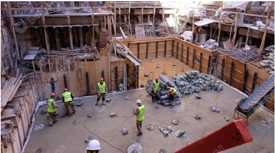
Рисунок 10. Применение бентонитового мата MASTERBENT для изоляции подвала при реконструкции жилого дома г. Москве.
