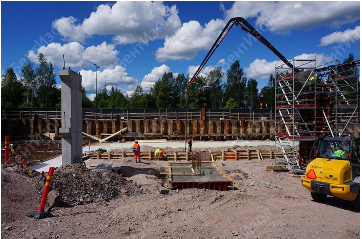
Рисунок 11. Применение бентонитового мата MASTERBENT для изоляции многоэтажной парковки жилого дома г. Эспоо (Финляндия).
