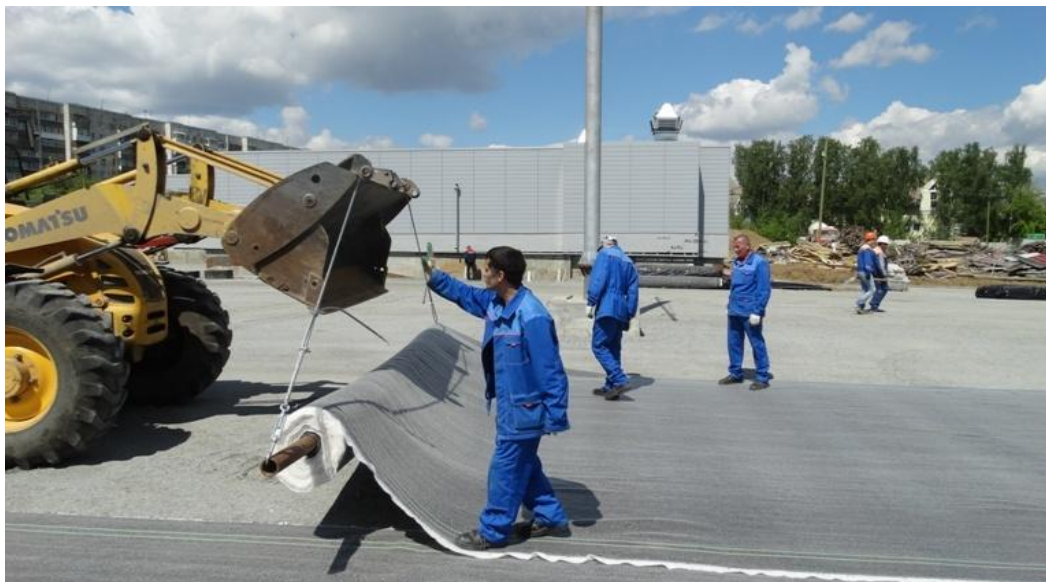
Рисунок 3. Процесс раскладки бентонитовых матов MASTERBENT P
