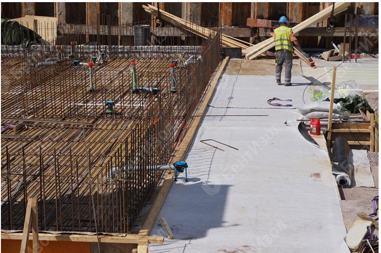
Рисунок 12. Применение бентонитового мата MASTERBENT для изоляции многоэтажной парковки жилого дома г. Эспоо (Финляндия).
