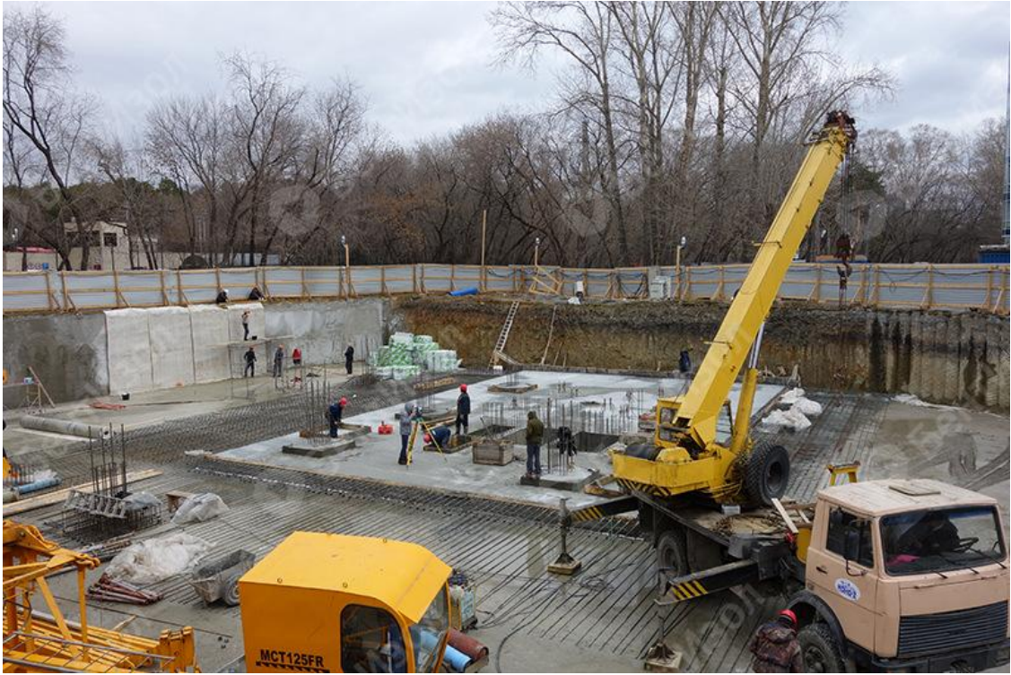
Рисунок 9. Применение бентонитового мата MASTERBENT для изоляции подвала спортивного комплекса в г. Екатеринбурге.
